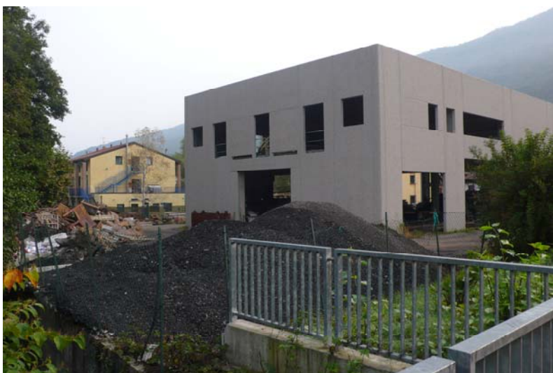
Figura 47. Area deposito materiale della Edilceresio
